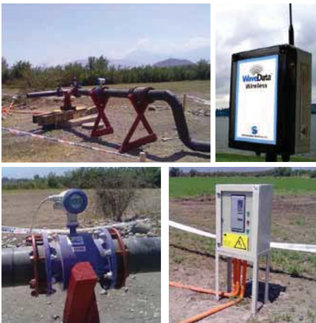
Recuadro 4: Equipos de monitoreo y control de acuíferos.
